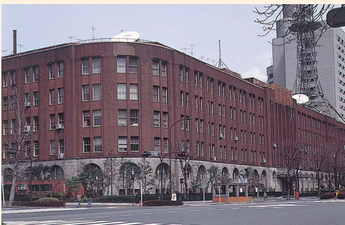
旧霞が関合同庁舎 (人事院ビル) 地下1階 (昭和31年11月20日～昭和35年3月24日)
