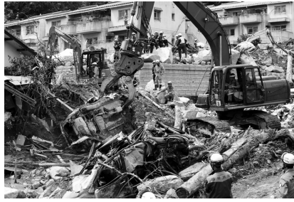
広島市土砂災害
