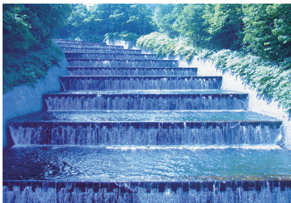
小樽水源地（階段式放水路）
