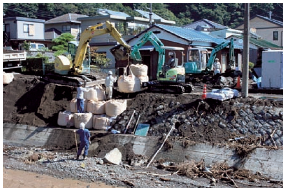
写真1 氾濫を起こした野沢川
