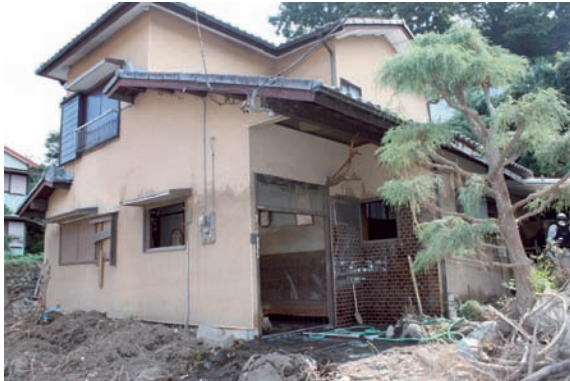
写真3 1階天井付近に達した浸水被害
