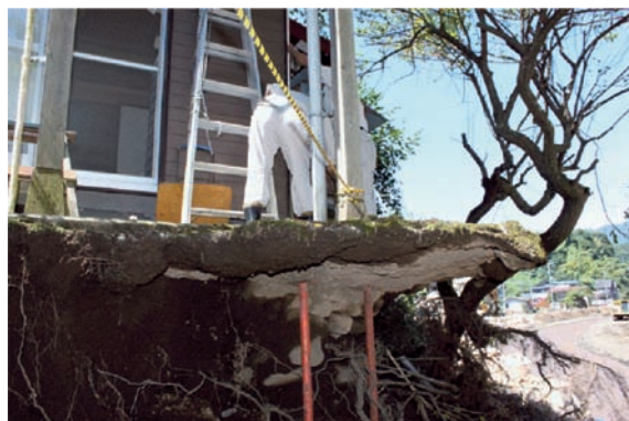
写真2 地盤が流出した住宅被害
