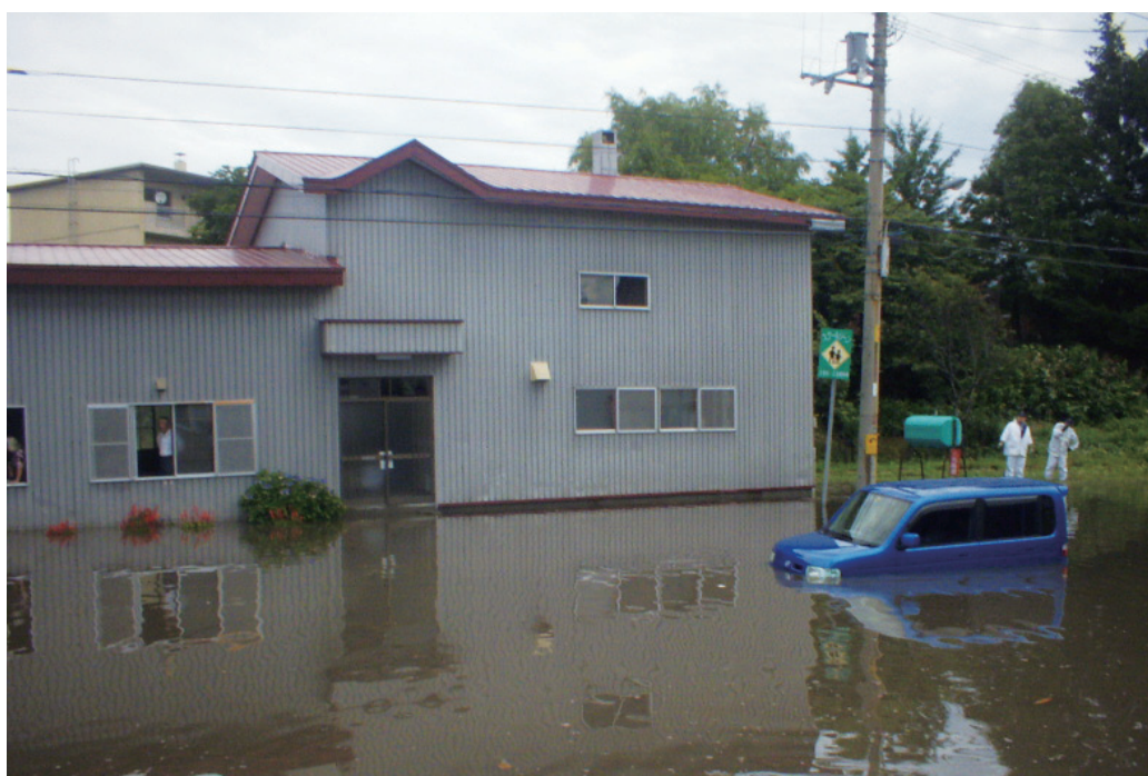
ゲリラ豪雨による局地的被害
