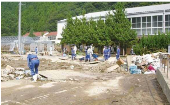
被災した学校での土砂作業中の様子
