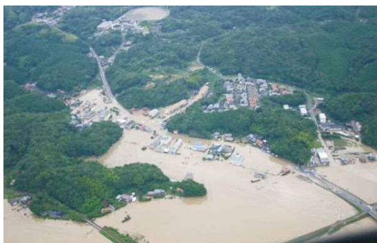
田万川江崎地区の被災状況（上空から撮影）
