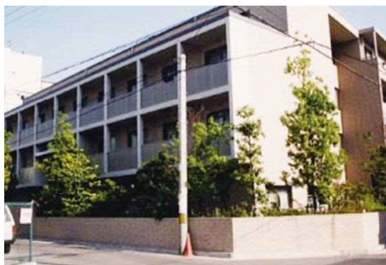
屋内消火栓が設置されていた建物
