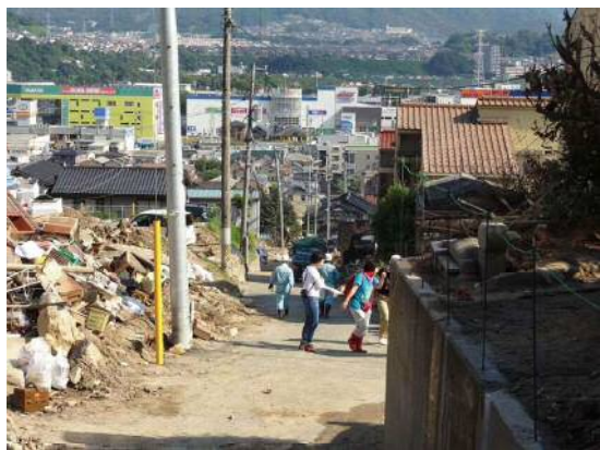
写真3 土石流の流路となった住宅地区内の道路 (安佐南区八木)
