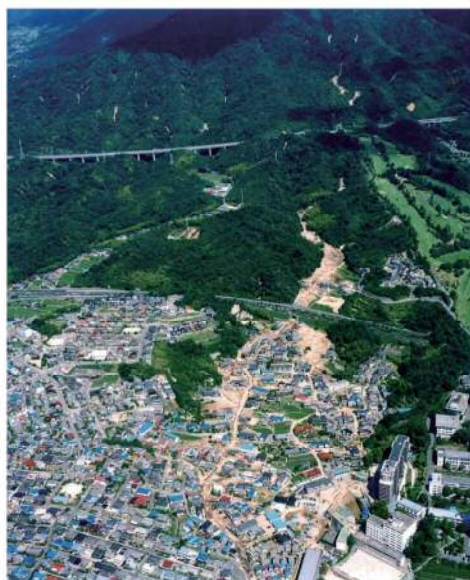
(土砂災害防止法制定の契機となった平成11年広島豪雨災害 広島市屋代川の氾濫状況)
