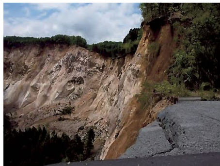
荒砥沢ダム(二迫川上流)
