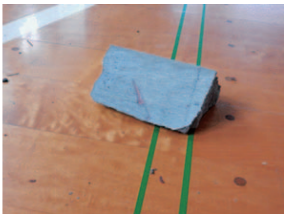
写真2 体育館天井から落下したコンクリート片（避難所が退避しておりけが人はなかった）
