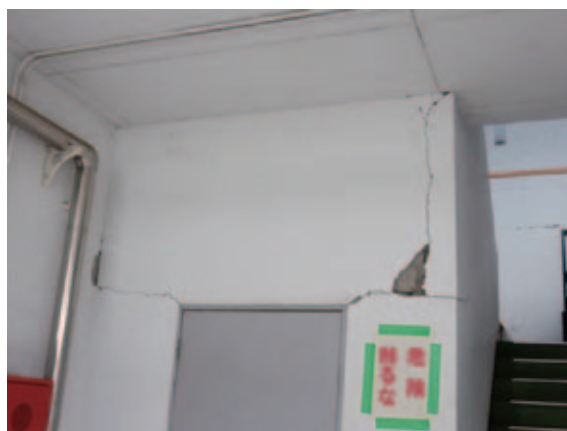
写真3 震災から8か月後でも手つかずの校内被害（避難所となった熊本工業高校）
