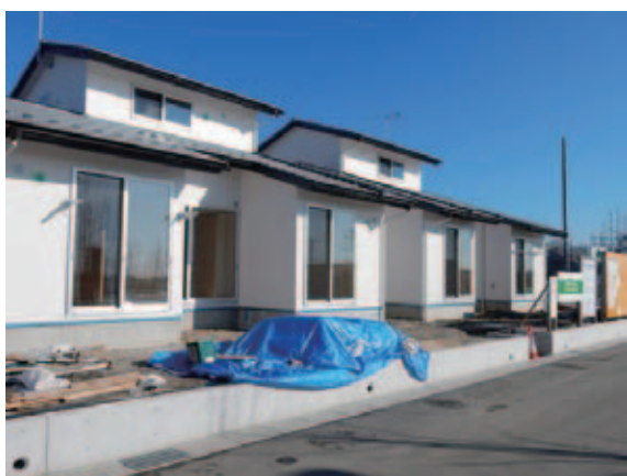
防災集団移転先に新築された住宅（宮城県岩沼市）
