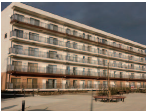
宮城県東松島市に建設された災害公営住宅
