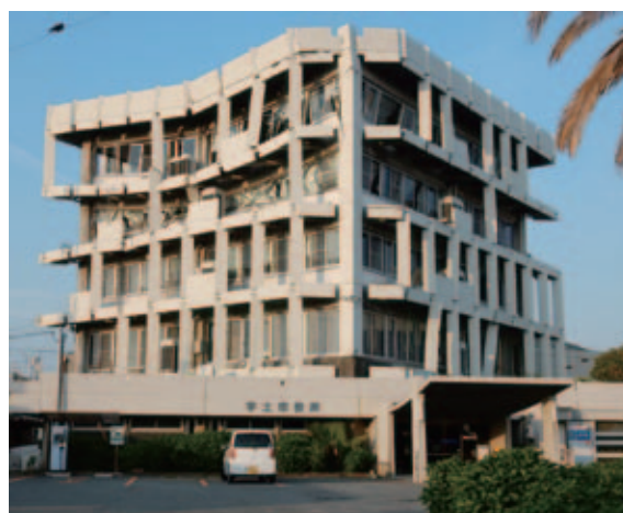
写真 5 全壊した宇土市役所庁舎
