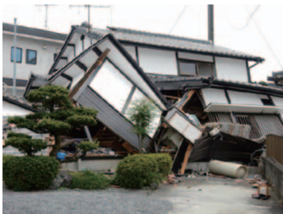
写真3 益城町での住宅被害
