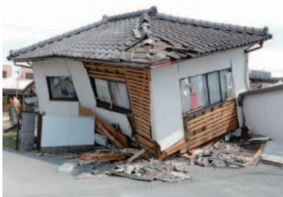
写真2 1階部分が層破壊を起こした住宅（益城町）
