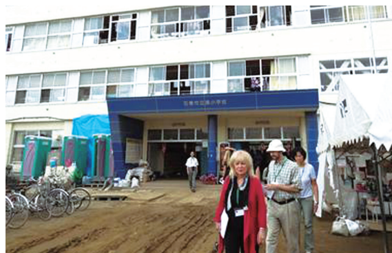
1階天井まで浸水しながら避難所となった 石巻市湊小学校
